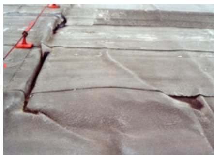
Důsledky zmenšení tepelné izolace z polystyrenu (Zdroj: Ing. Marek Novotný, Ph.D.)
