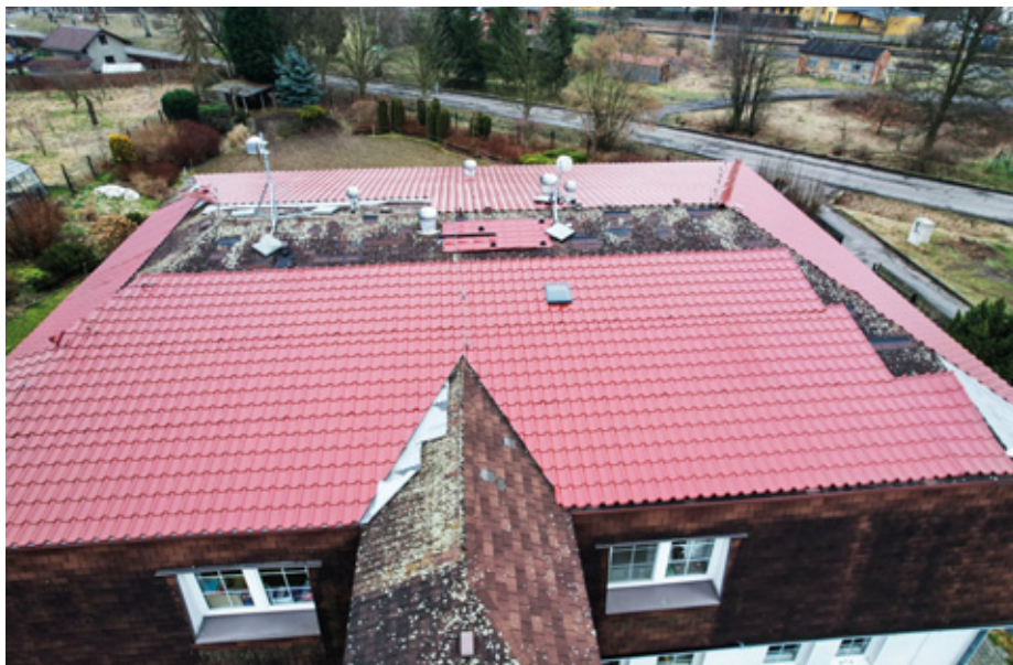
Celkový pohled na valbovou střechu s mansardami - napojení střešní krytiny a úžlabí je bez klempířských prvků.
