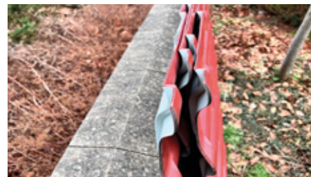
Zbývá uskladněná krytina nastojato u plotu - proti všem pravidlům.
