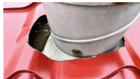
Opět oříznuto úhlovou bruskou, a ještě proti vodě.
