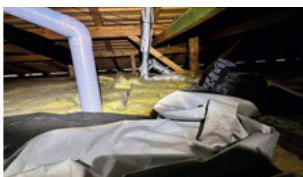
Pod místa opravovaných defektů ve střeše (zatékajících) zhotovitel natáhl DHV, aby investor si myslel, že firma vše řádně opravila.
