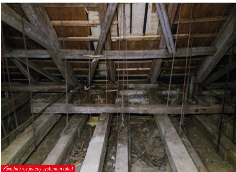
Rozpojená vazba v původním krovu
